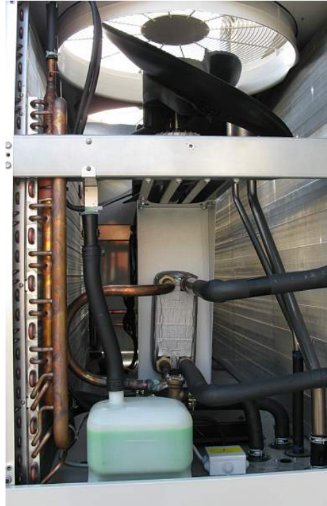
Slika 10. Unutrašnji izgled kondenzatorskog agregata
