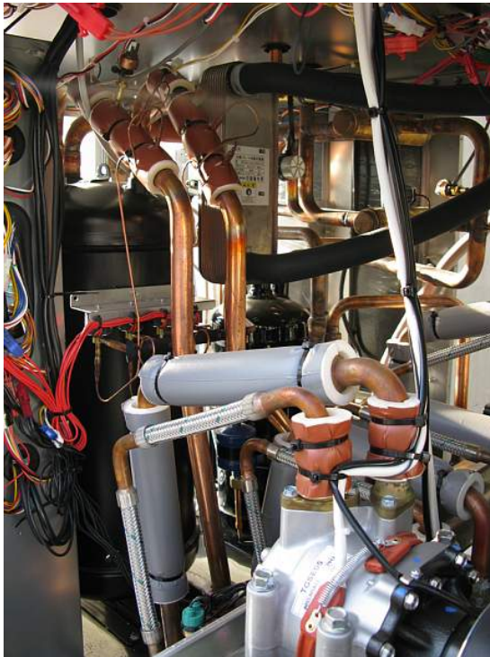
Slika 9. Deo kondenzatorskog agregata gasne toplotne pumpe
