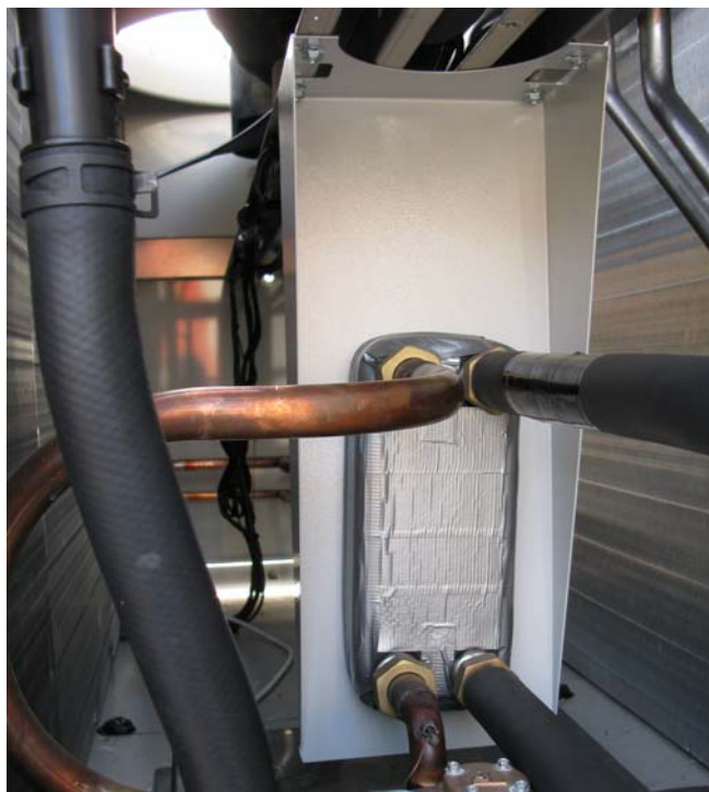
Slika 6. Pločasti razmenjivač toplote za pripremu sanitarne tople vode
